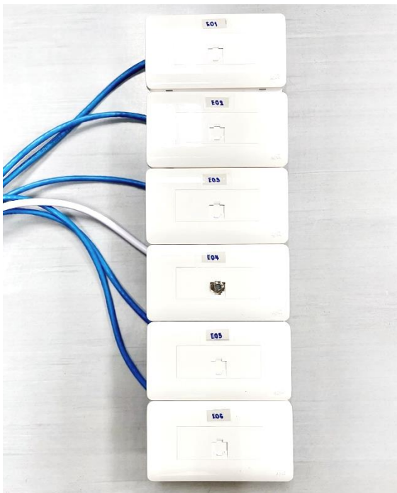
รูปที่ 8 และ 9 แสดงตัวอย่างการ Label และการเชื่อมต่อที่ EQUIPMENT OUTLET
